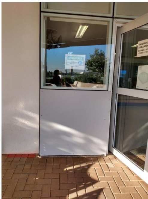
Imagem 9 – local de instalação do item 8 (Lote 1).
