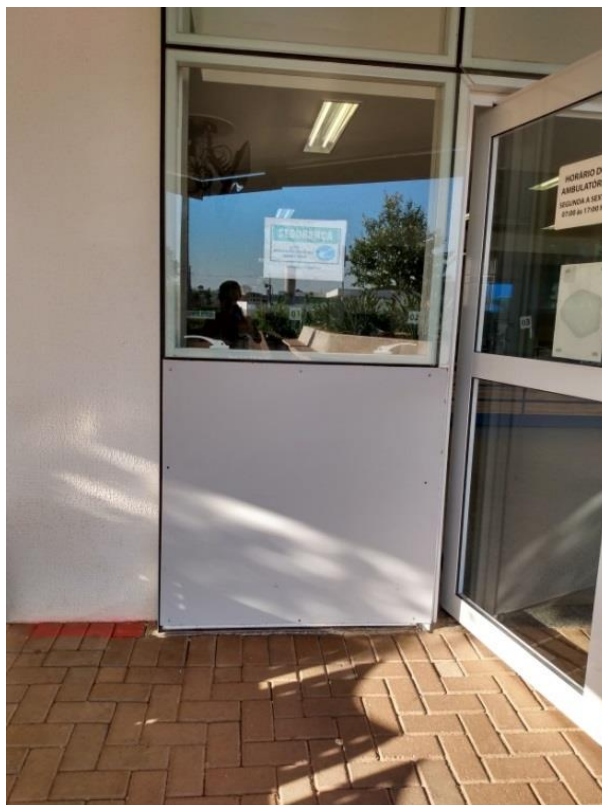
Imagem 9 – local de instalação do item 8 (Lote 1).
